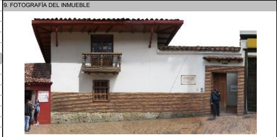
Fuente: Equipo Fotografía PEMP Patrimonio Inmueble
